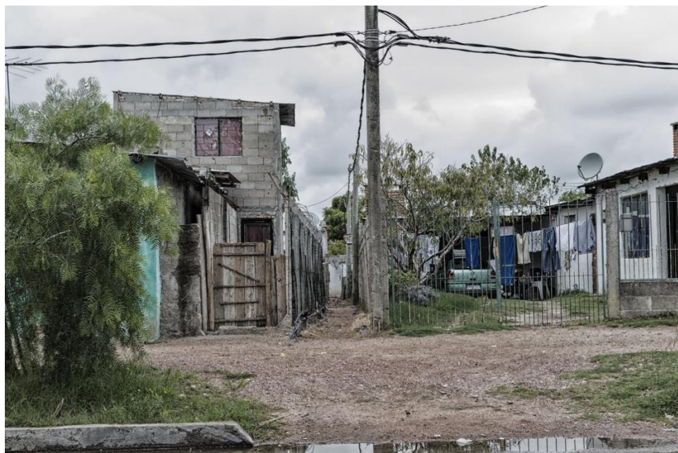
4. Pasajes entre viviendas autoconstruidas del asentamiento Gruta de Lourdes, de décadas de existencia. Una espacialidad laberíntica formalizada con el paso del tiempo según el eje principal del camino de las Instrucciones y tensionada por la Gruta en frente. Detrás, el arroyo Miguelete.
